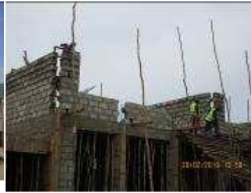
Fig3. Elévation des murs de l'étage (6 auditoires)
