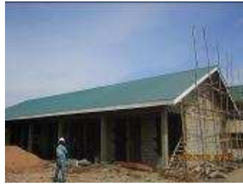
Fig 2 Finissage de toiture de bâtiment de bureaux de sections.
